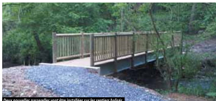
Deux nouvelles passerelles vont être installées sur les sentiers balisés.
