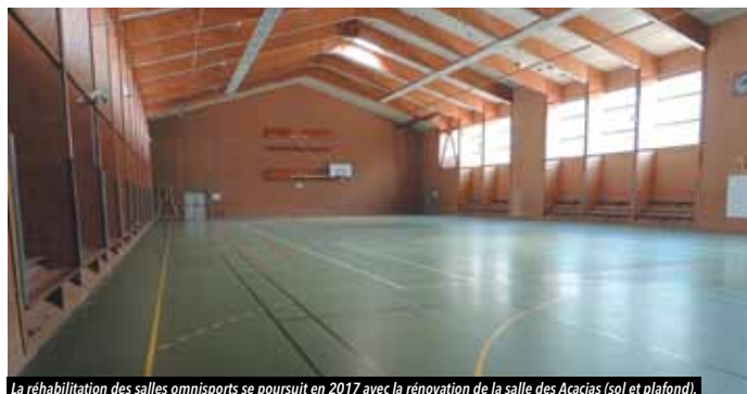
La réhabilitation des salles omnisports se poursuit en 2017 avec la rénovation de la salle des Acacias (sol et plafond).
